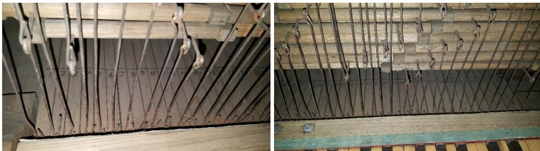
Figura 30 – Pormenor da mecânica de notas do instrumento (interface abreviação / bastidor do teclado manual), antes da presente intervenção de conservação e restauro.
