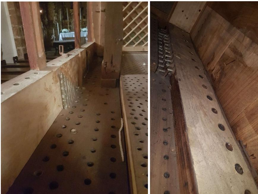
Figura 24 – À esq., tabuão correspondente à intonação do órgão, *Flautado de 6* (mão esquerda); à dir., tabuão correspondente ao registo *Violam* (mão esquerda), durante a desmontagem do instrumento.
