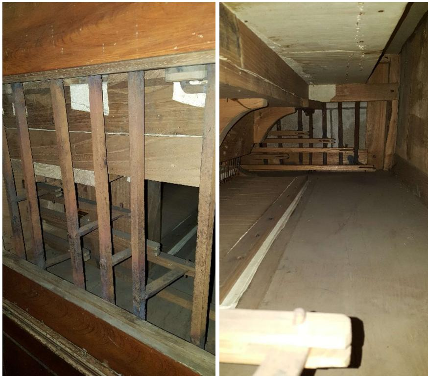
Figura 26 – Mecânica de registos original composta por sarilhos em ferro forjado e braços horizontais em madeira, antes da presente intervenção.
